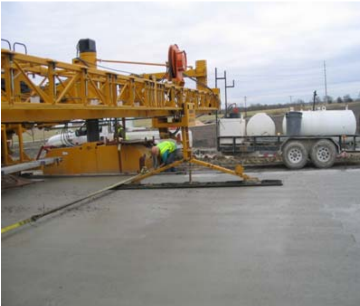
Figure 9-51. Longitudinal float.
